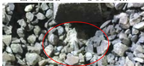
図 8 健全なまくらぎ下面のバラスト
