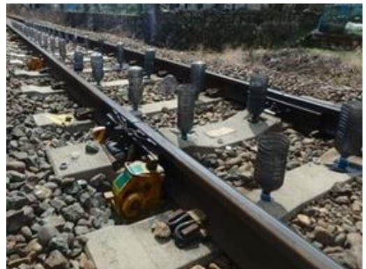
図-5 施工実施状況
