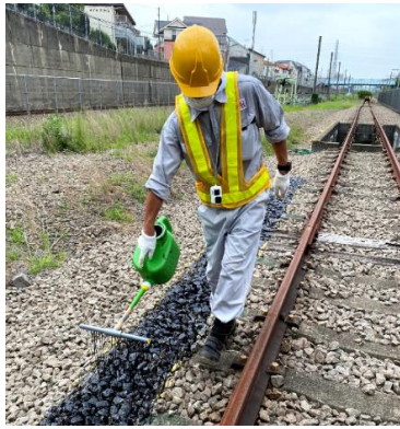
図 - 1 道床安定剤散布の様子
