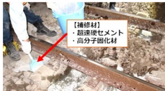
(a) 補修材投入
