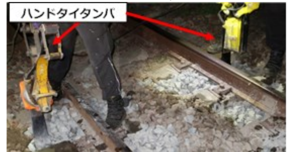
(b) つき固め補修
