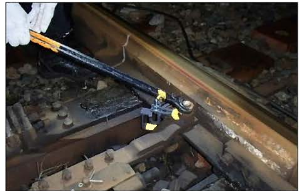
図—7 「ウィット用スパナ」使用状況
