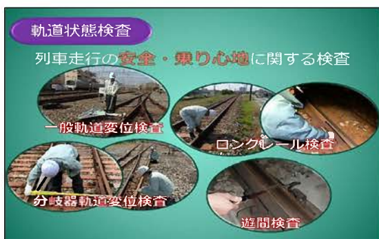
図—2 軌道状態検査項目
