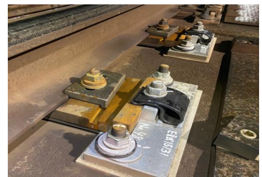
図7 改良型締結装置
