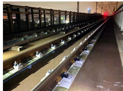
図6 敷設中の鋼直結軌道用レール締結装置
