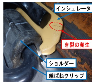
図 4 インシュレータのき裂
