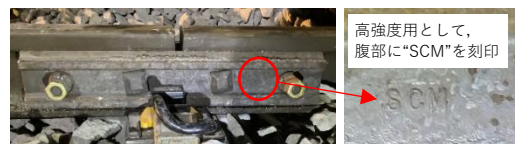
図-9 高強度异形継目板(継目落ち用)
