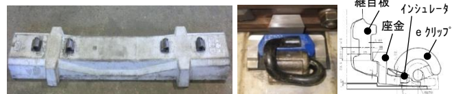
図-2 下級線継目用 PC まくらぎ 図-3 締結装置 図-4 締結構造
