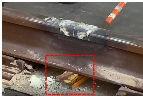
図-2 落込み防止対策：くさび挿入（赤枠内）
