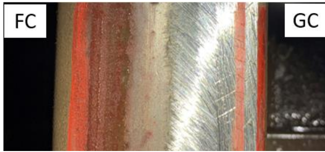
図-2 1パス後の曲線外軌レール写真 (赤色部分が砥石未接触箇所)
