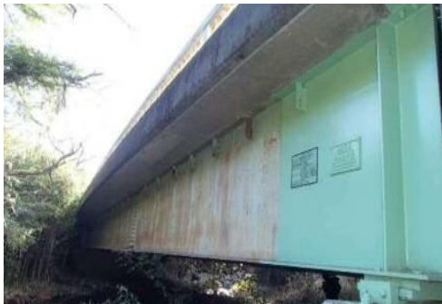
写真-1 部分塗装後の外観 (新長茂橋)
