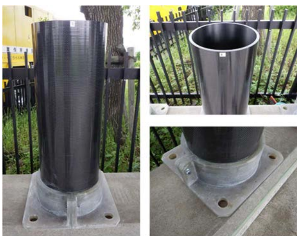
写真-1 CFRP製段差防止構造
