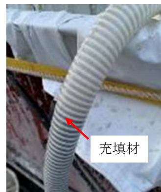
写真2 排水ホースへの充填材の流入状況の確認
