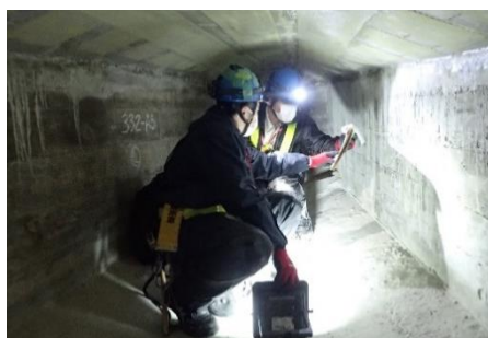
写真-1 内面点検(箱桁内)の作業状況
