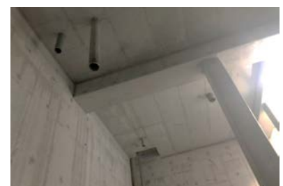
写真-5 補修完了
