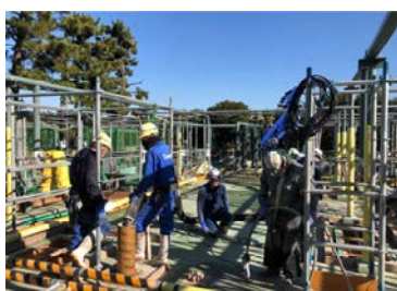
写真-4 スラブ打設状況
