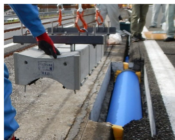
写真 3 PCa ブロック設置状況 (開発工法③, ④)
