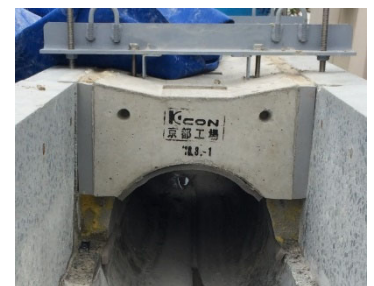
写真 4 完成状況 (開発工法⑦)
