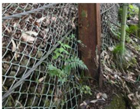
写真-1 落石防護柵支柱（点検時）
