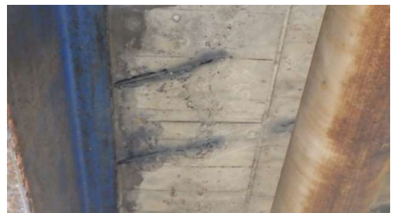
写真1 床版下面の状況
