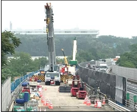
図-1 既設橋床版取替工事状況
