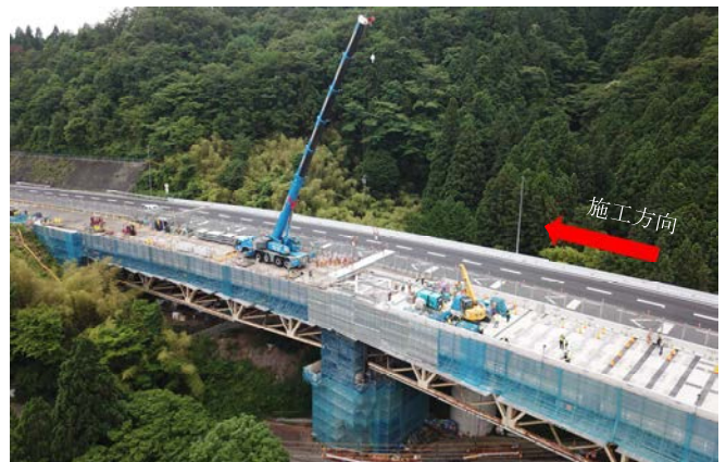
写真-2 鋼トラス桁橋の床版取替状況
