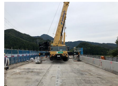
図-2 300t 吊オールテレーンクレーン
