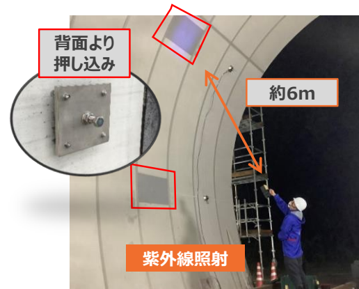
図4 実物大模擬トンネルでの検証状況
