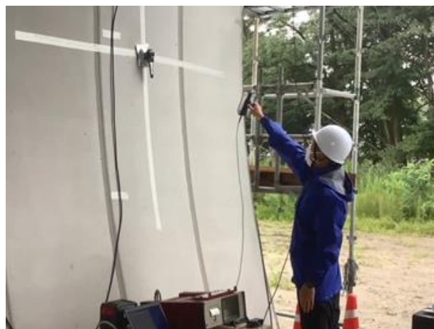
写真 1 軸力センサの測定状況
