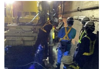
写真-2 施工状況
