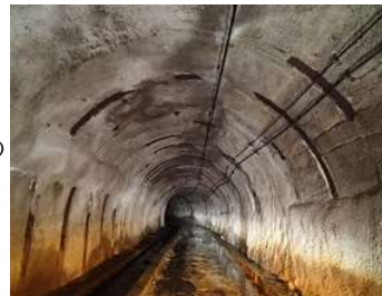
写-1 試験施工箇所
