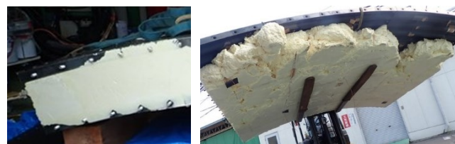
注入孔側妻部 下面側
