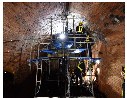
図3 試験施工状況
