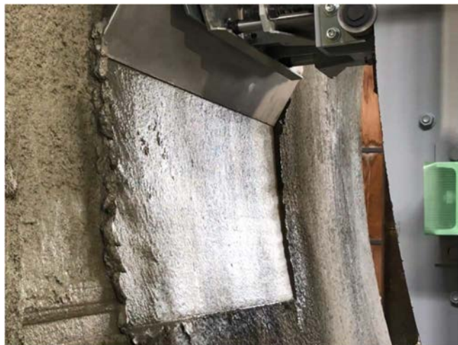
写真-5 自動均し機実証試験
