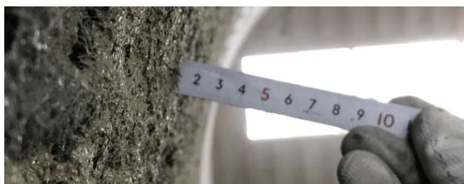
写真-6 一次吹付け厚確認 (上)
