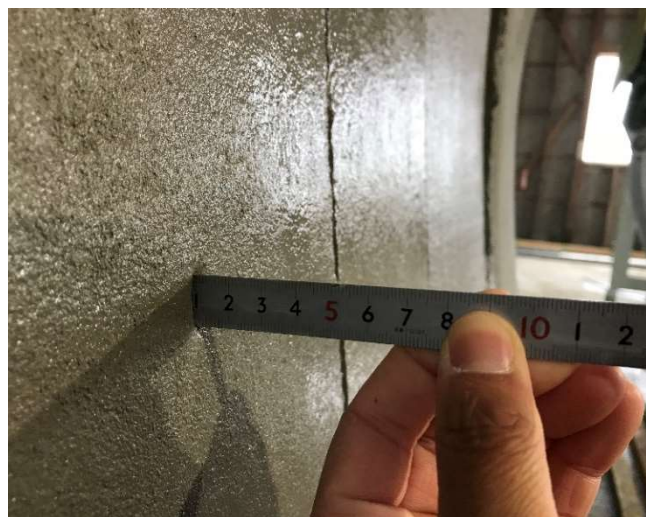
写真-8 均し仕上げ後巻厚確認
