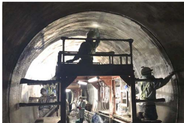
写真-1 導水路トンネル作業状況
