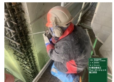
写真-4 ウォータージェット施工状況
