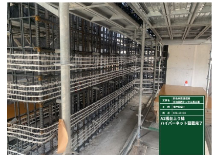
写真-7 繊維型補強状況
