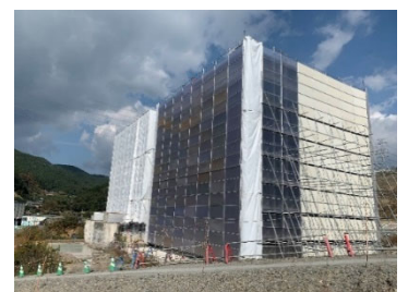
写真-3 防音パネル設置状況
