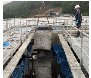
写真-1 ブロック撤去状況
