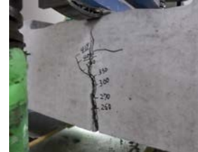
図-3 損傷まくらぎ
