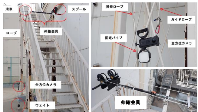
写真-1 全方位カメラ昇降点検システム
