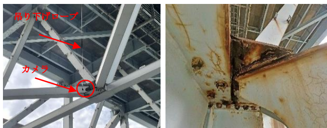
写真-4 トラス橋点検状況と損傷状況
