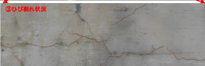
写真-5 ひび割れ自動抽出技術の活用
