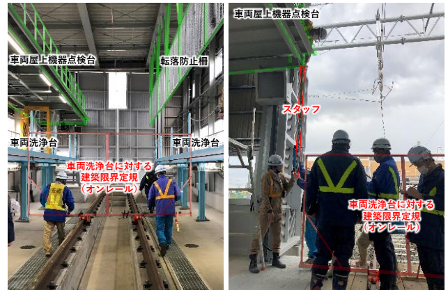
図-1 左 建築限界定規 右 高所実測状況
