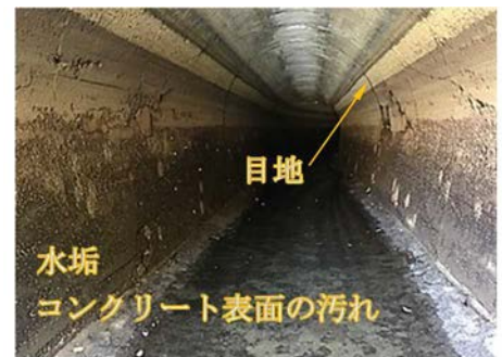
写真1 水路トンネル内部の例
