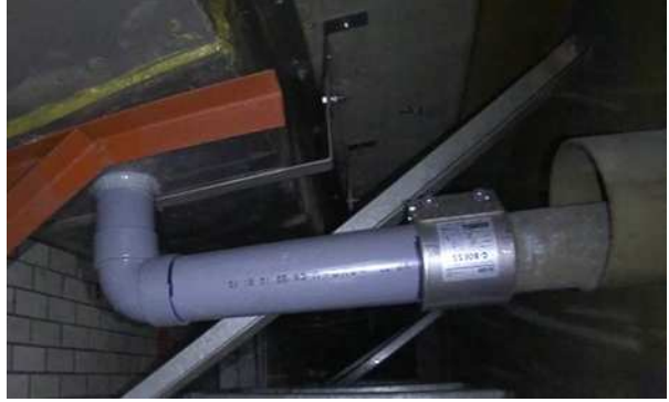
図5 排水管継手部の撮影確認例
