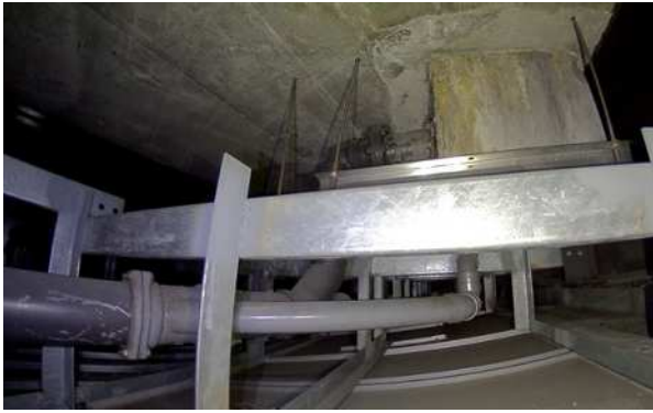
図2 UAVで捉えた排水管の状況
