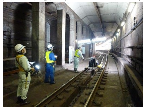
写真1 従来のトンネル検査
