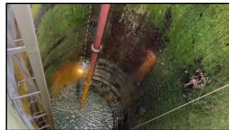
写真-1 集水井撮影状況
