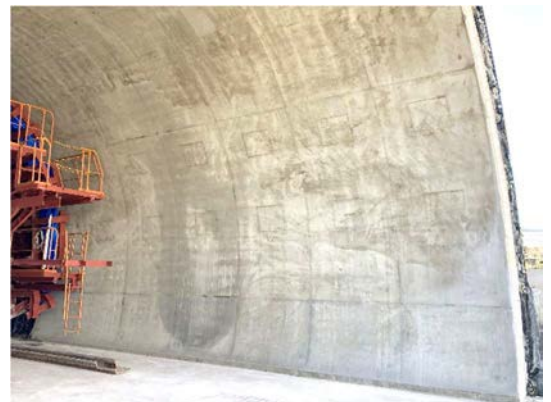
写真-3 覆工側面の出来映え
