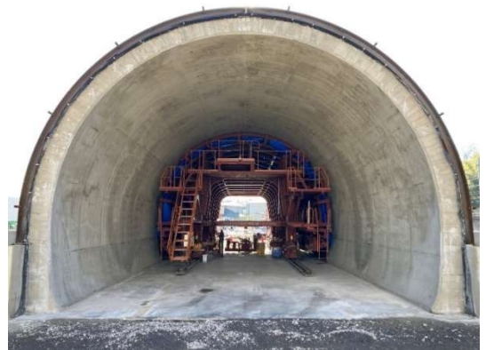
写真-2 覆工コンクリート出来映え
