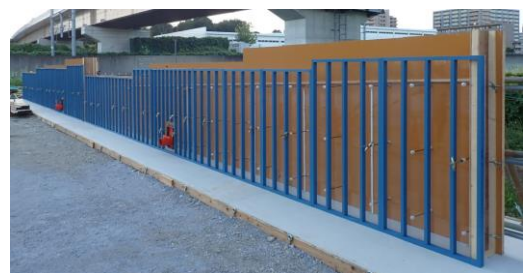
写真-1 壁状模擬型枠外観
