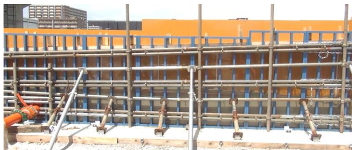
写真-2 コンクリート圧入状況
