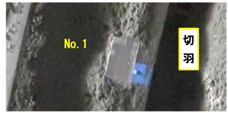
写真-2 無線 DL の吹付け埋設状況
