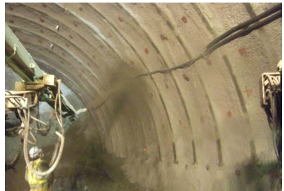
写真-3 従来のB計測における計測線防護工の例
