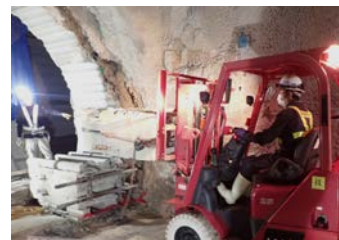
写真-1 覆工撤去状況
