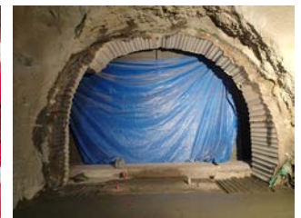
写真-2 覆工撤去完了
