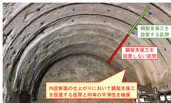
写真-3 掘削面の平滑な仕上がり
