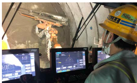
写真-2 穿孔操作の状況
