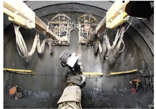
図-1 爆薬装填作業 従来状況
