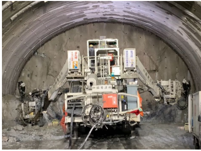
写真-1 穿孔作業状況
