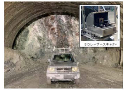
写真-3 3D スキャナー計測状況
