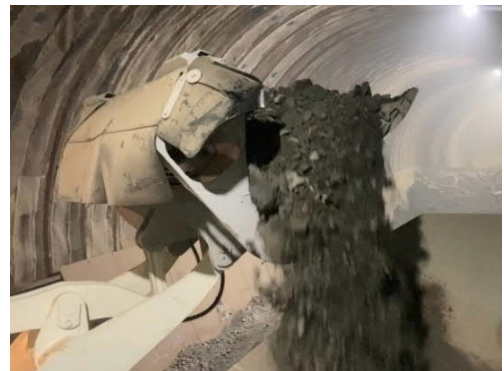
図7. クラッシャーへの投入状況
