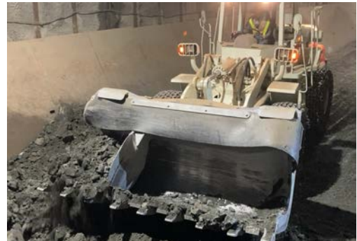
図6. 大型機排土状況
