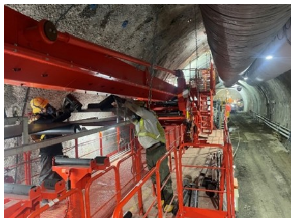
写真-2 中間フレーム組立状況
