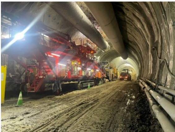
写真-1 日々延伸型テールピース設置状況
