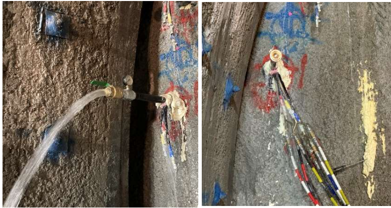
写真3 湧水状況(孔 No. 1)
