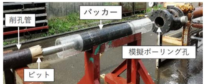
図-6 パッカー拡張状況
