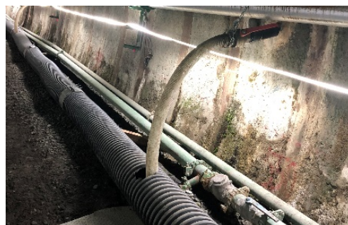
図-4 施工完了状況（仮設）
